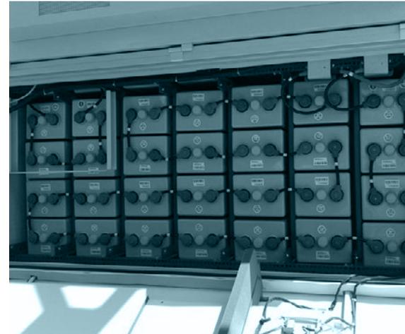
**Перевод оборудования БС в дорогие часы на питание от АКБ (с последующей зарядкой АКБ в дешевые часы) или работа от ДГУ.**
